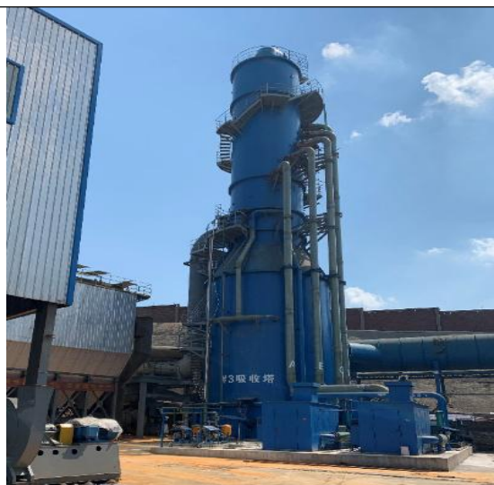
熔炼炉水喷淋塔
