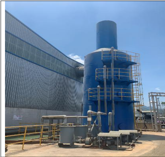
原料车间除尘系统排气筒
