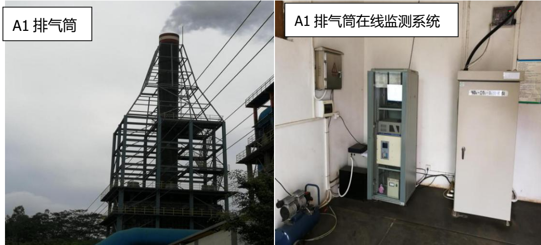
图 8.8-1 A1 排气口在线监测系统
